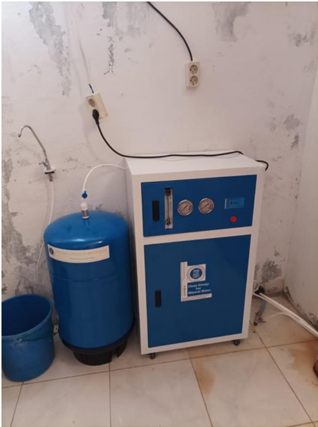
Gambar 3. Hasil Instalasi Mesin RO
