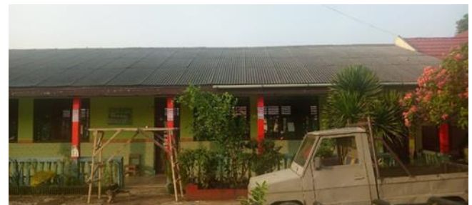
Gambar 8. Proses Instalasi Talang
